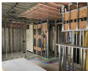
通電前の屋内作業に
